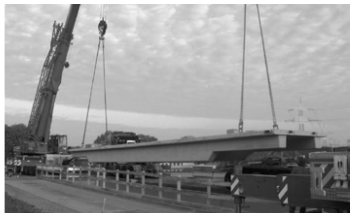
Die Wägeplattform für die zweite Fahrzeugwaage wurde mit Hilfe eines Schwerlastkrans eingebaut.
